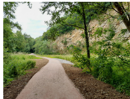
Piste partie nord avant dépôt du sable
