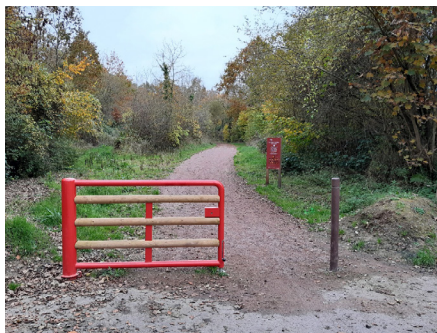
Barrière accès nord
