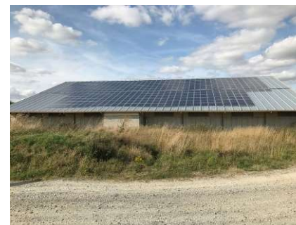
Production électrique photovoltaïque
