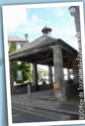
Treize piles surmontées de chapiteaux en granit soutiennent la charpente de la halle, qui se distingue par le montage chevillé de son ossature en bois. Un clocheton orne la toiture. Élément du patrimoine historique et culturel de Bény-Bocage, la halle aux grains fut construite entre 1710 et 1714 pour la vente des grains et du beurre. A proximité, une fontaine dotée d'un mécanisme en fonte fait jaillir l'eau continûment.
